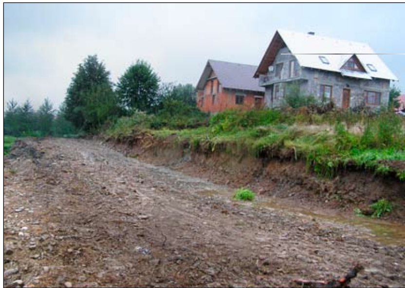
Nová ulica Nad ihriskom v Gaceli zrealizovaná cez obecný podnik RABČAN, s. r. o. umožnila prístup k viacerým stavebným pozemkom EFOTO – V. BRIŠ
