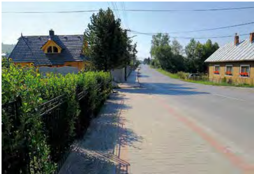
2. 8. 2018 Dokončený zrekonštruovaný chodník pre chodcov v dolnej časti obce FOTO V. BRIŠ
