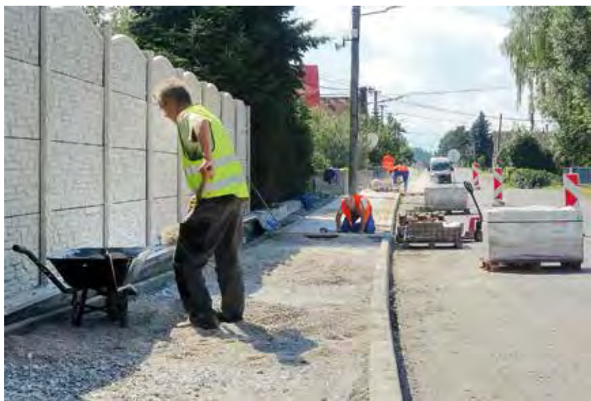
5. 6. 2018 Práce na rekonštrukcii chodníka pre peších v dolnej časti obce vedľa Hlavnej cesty. Pred 28 rokmi na mieste chodníka bola len priekopa a úzka Hlavná cesta. Vtedy tu došlo k smrtelnej nehode dieťaťa kvôli chýbajúcemu chodníku pre peších. Takto zrekonštruovaný chodník zvýši bezpečnosť v obci. Potrebne je, aby si viacerí naši občania uvedomili, že chodníky sú pre chodcov a že sa na nich neparkujú autá!
