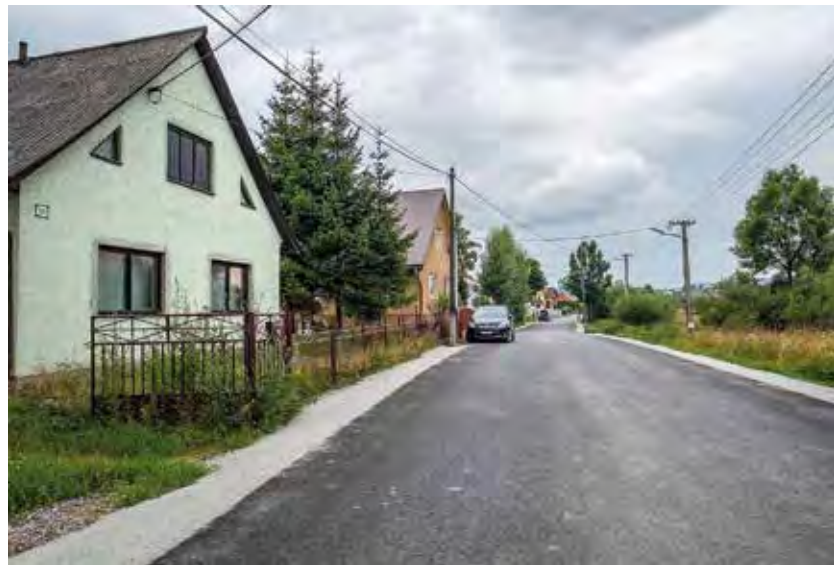
2. 8. 2018 Ulica Mokrá v časti obce „Za vodou“ konečne opravená a pokrytá novým asfaltom. Cesta bola zničená a neopravená od výstavby kanalizačného zberača v roku 2003.
