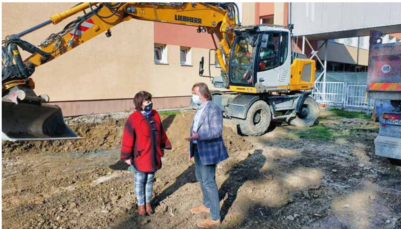
29. 10. 2020 Prvý výkop pre základný kameň prístavby Základnej školy v Rabči
