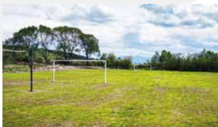
21. 5. 2014 Pohľad na časť dokončeného športovo-oddychového areálu na dolnom konci
