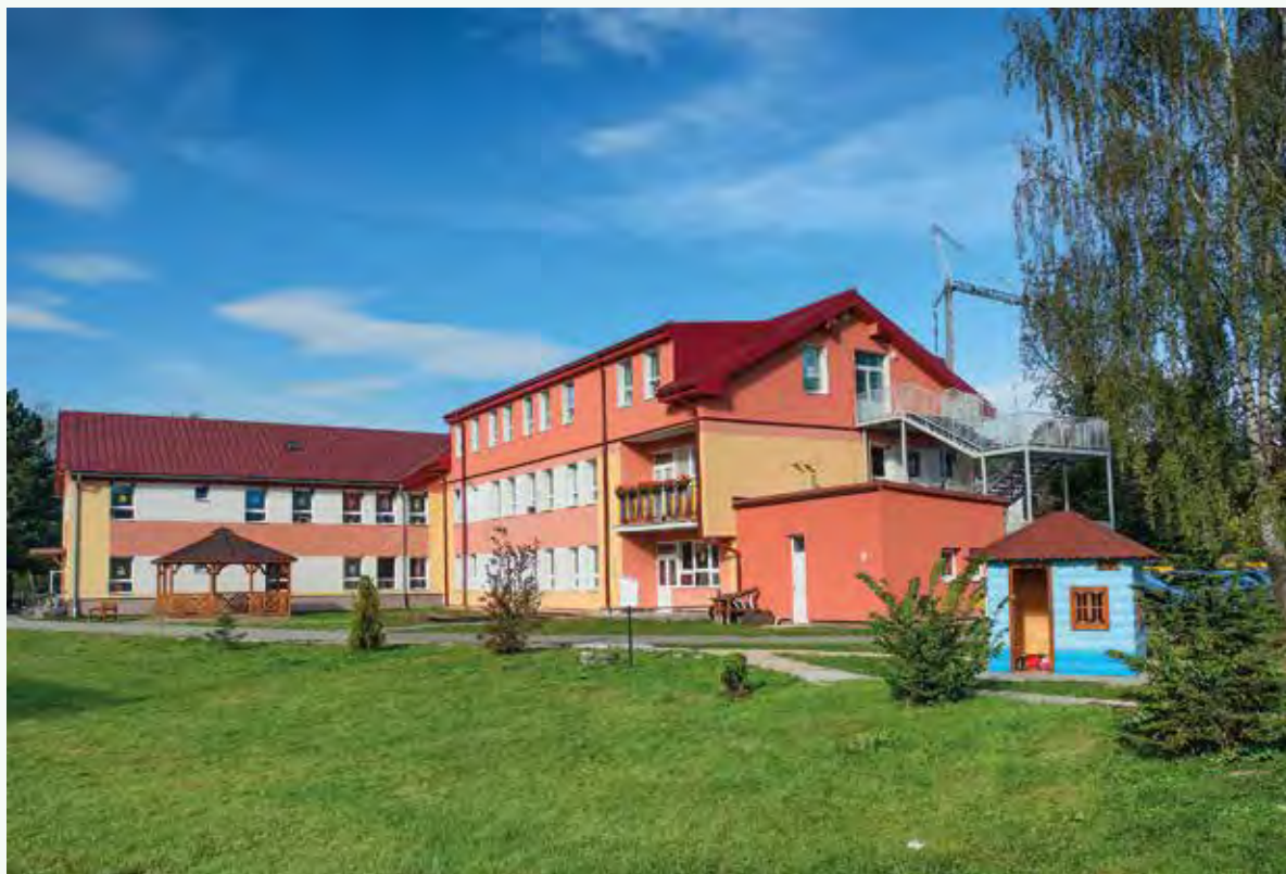
24. 9. 2024 Materská škola v Gaceli – čelný pohľad
