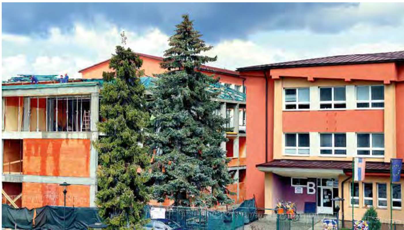
20. 4. 2021 Prístavba základnej školy
