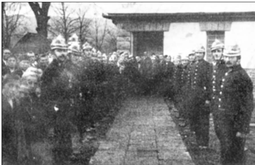
1930 Členovia hasičského zboru pomáhali počas slávnosti rekonštrukcie kostola
